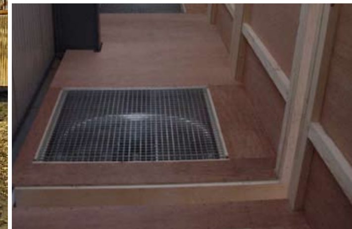
Zorg ervoor dat boven een ventilator een beschermrooster is gemonteerd.
