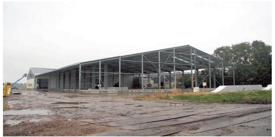
Dankzij de nieuwe oprit lopen bouwvakkers en bollenkwekers elkaar niet in de weg.
