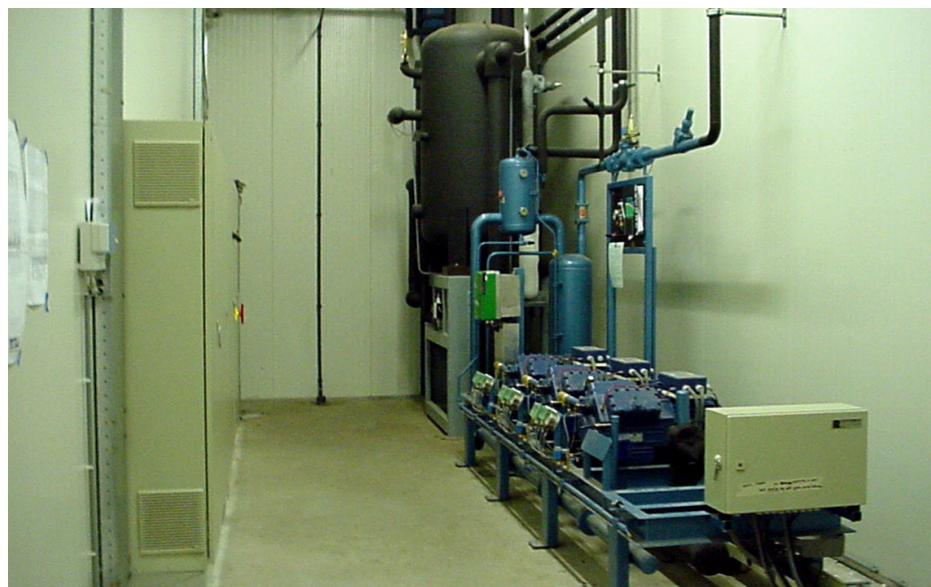
Voor retrofitten van pompsystemen met R22 is R507/R404A meestal het enige, helaas slechte, alternatief.
