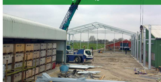
De nieuwe schuur hier nog in de stijgers
