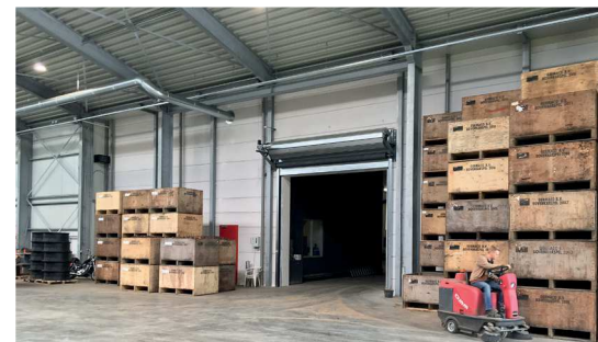
180 min. brandwerende stalen roldeur tegen Ytongwand
