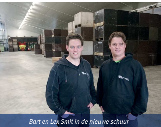
Nieuwe schuur van ACM Smit in aanbouw
