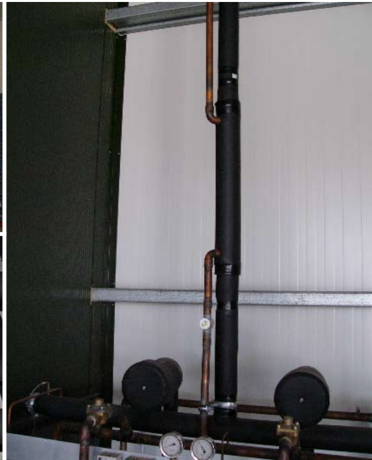
Bij gebruik van R507A is onderkoeling een vereiste. Dat kan zoals hier soms heel eenvoudig door de vloeistof te koelen met koud zuiggas. Foto: AgroFocus
