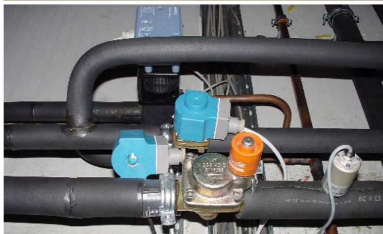
Onder: als nieuwe expansieventielen nodig zijn, is dit een goed moment om elektronische expansieventielen te monteren. Foto: AgroFocus
